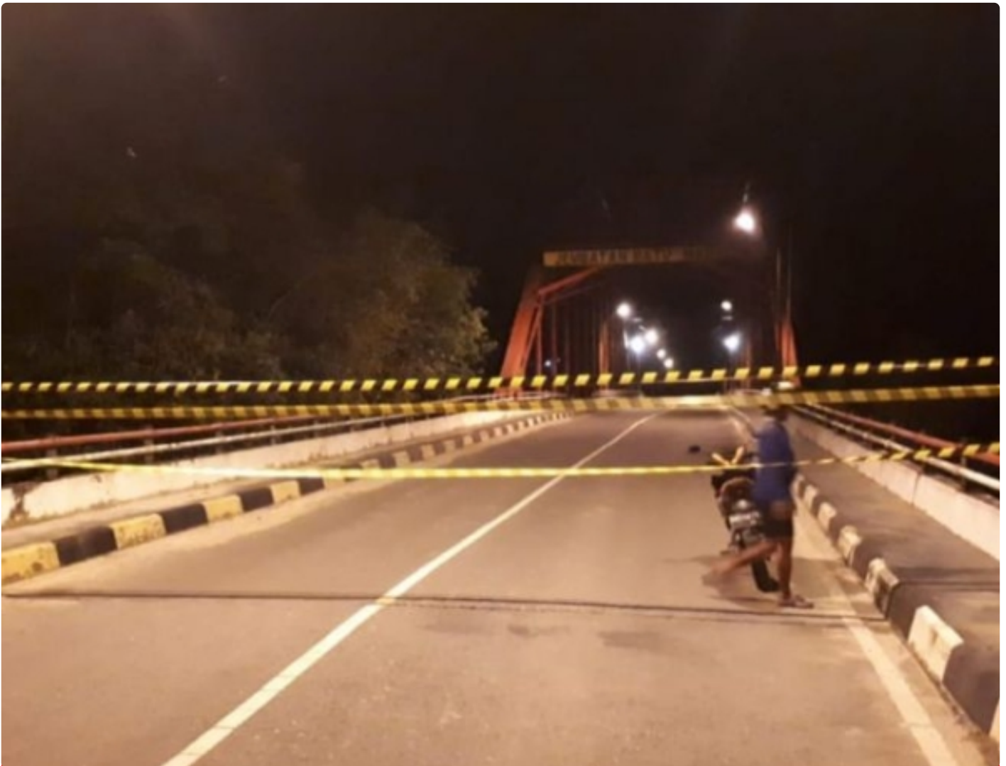
Jembatan Batu Mahasur Kuala Kurun Dipasang Tanda Garis Polisi (Police Line)
